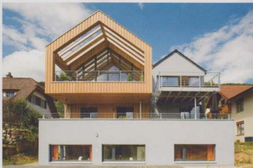
Dank der langjährigen Erfahrung im Kellerbau sind für das Unternehmen auch steile Hanglagen und ein hoher Grundwasserstand kein Problem.
