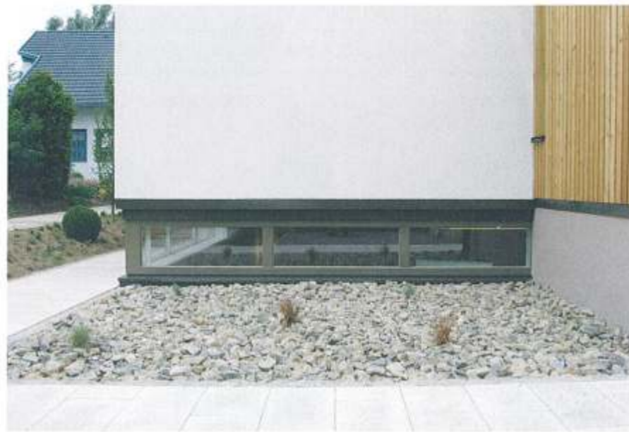
Um das Untergeschoss mit Tageslicht zu versorgen, wurde bei diesem Beispiel des Kellerspezialisten Knecht ein schmales, aber umlaufendes Lichtband eingesetzt, das die Sonnenstrahlen ins Innere leitet. Sie können aber auch spezielle Lichtschächte einbauen oder eine künstliche Abböschung auf einer Seite des Hauses anlegen. Foto: Knecht
