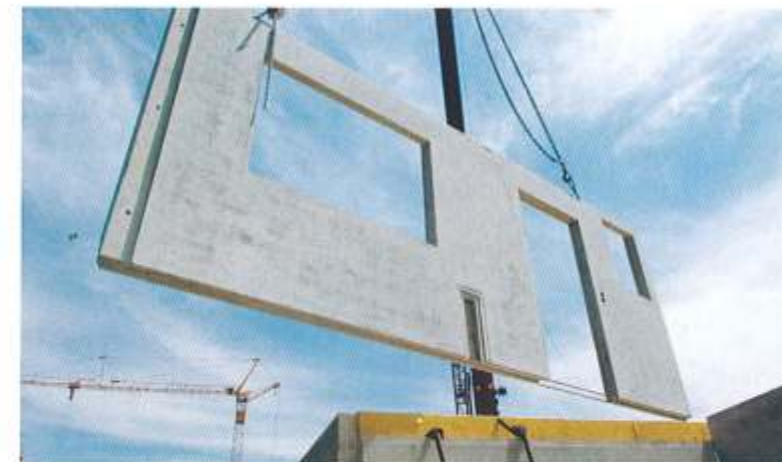
Auf Wunsch wird in die Fertigkeller von Dennert bereits das Elektroerohrsystem mit allen Elektrorosen eingebaut. Steht das Untergeschoss, kann der Elektriker sofort mit dem Einziehen der Leitungen beginnen. Foto: dennert-baustoffe.de
